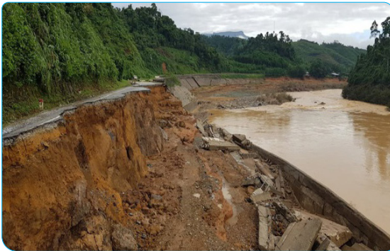
Hình 6.1. Sạt lở đất tại huyện Phước Sơn (năm 2020)
