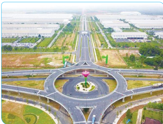
Hình 4.4. Tuyến đường tại khu kinh tế mở Chu Lai, Quảng Nam
