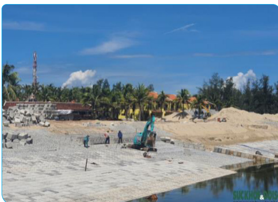
Hình 6.23. Xây dựng các tuyến đê ở bờ biển Hội An
