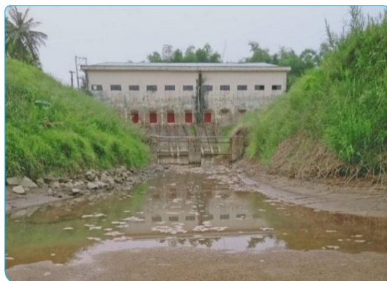
Hình 6.6. Trạm bơm Ái Nghĩa bị cạn nước
