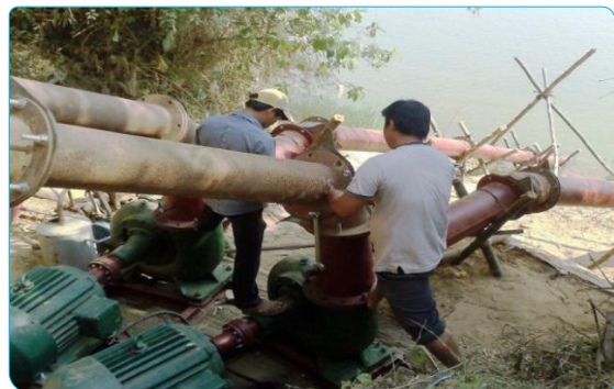
Hình 6.4. Trạm bơm dã chiến được lắp đặt để chống hạn tại huyện Duy Xuyên (năm 2022)
